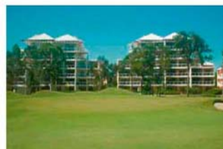
2000 平方米筏板在地下水位线以下 2.5 米, 可承受六层楼高, 仍保持防水性。
